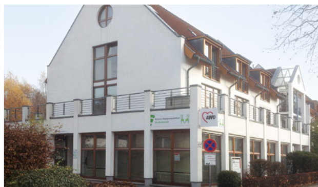
AWO Begegnungszentrum in Detmold
